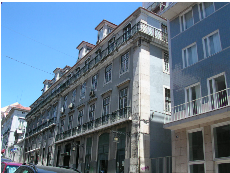
Figura 6 – Edifícios na rua do Alecrim, n.º 38 a 54, vista geral (fachada principal), fotografia de Inês Pais (2006) (SIPA, FOTO.00808816).
