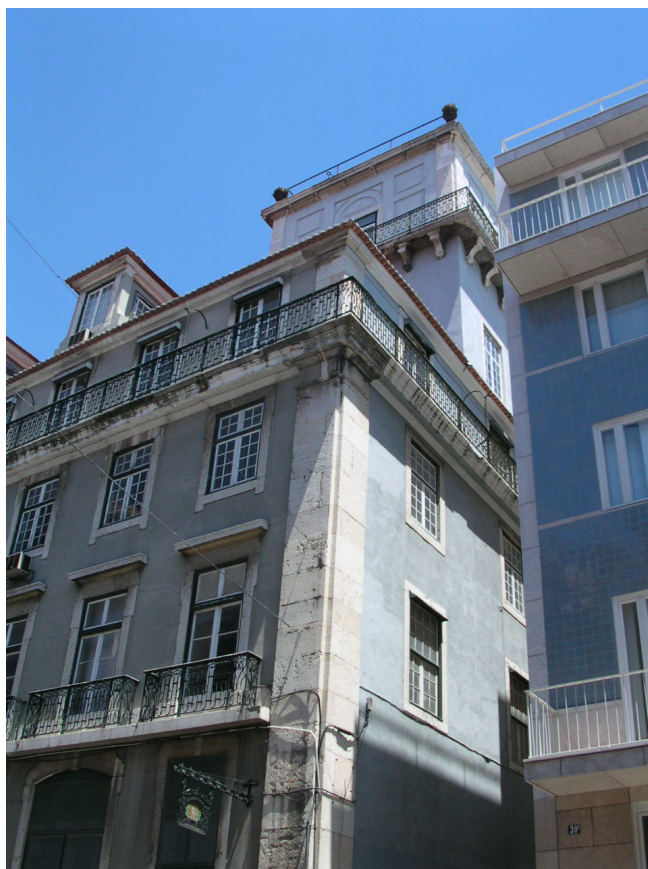
Figura 9 – Edifícios na rua do Alecrim, n.º 38 a 54, fachadas principal, lateral direita e mirante (prédio sul), fotografia de Inês Pais, 2006, (SIPA, FOTO.00808817).
