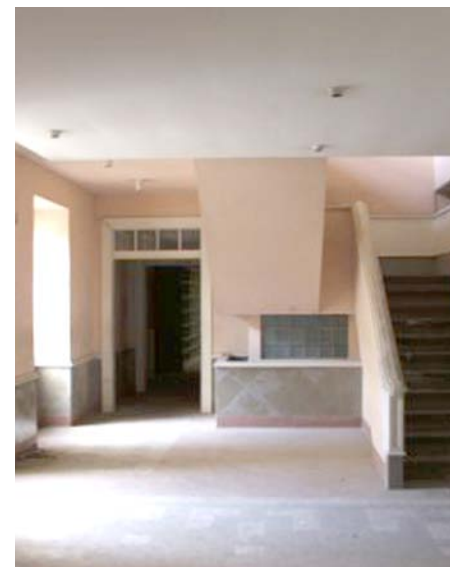
Ilustração 16 Piso 1, actual sala de distribuição situada após a escadaria de aparato.
