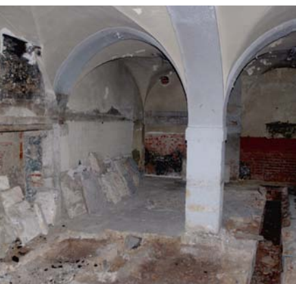
Ilustração 5 Fotografia de divisões no piso 0 - cozinha, divisão privada e cocheira/cavaliária.
