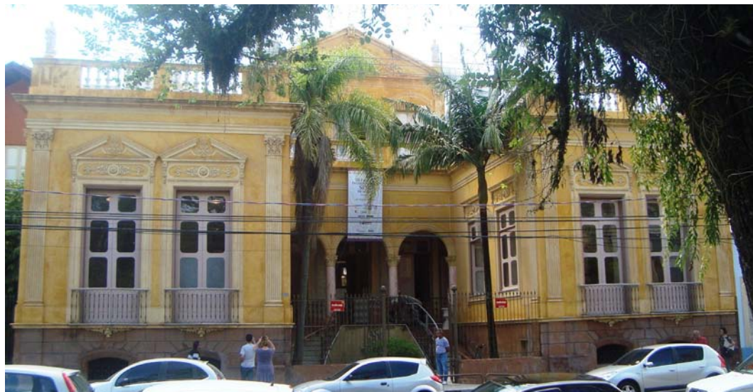
Ilustração 7 Fachada da antiga residência do Barão de São Luis (1879), Pelotas, RS.
