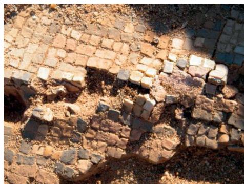
Fig. 4 – Empolamento e fissuração.
