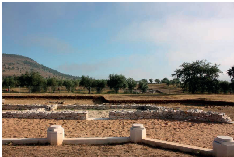
Fig. 2 - Vista da parte Norte da pars urbana da Villa romana do Rabaçal onde se encontram os banhos e pars rustica . Fotografia de Filomena Limão.
