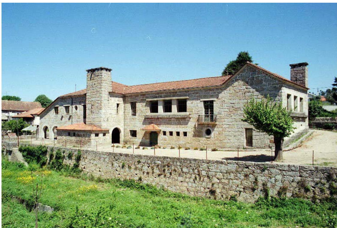
Figure 3. School-Canteen Salazar. Vimieiro, Santa Comba Dão. Current photo. Archive DGEMN: SIPA, IPA nº PT021814080009, FOTO.4051935.
