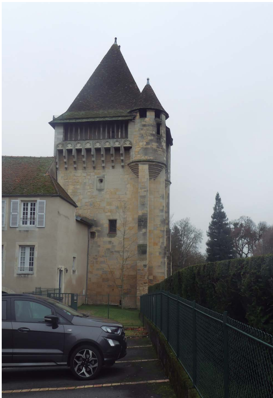
Fig. 8 – Parement Nord de la Porte du Croux où est visible, au second niveau, la canonnière.
