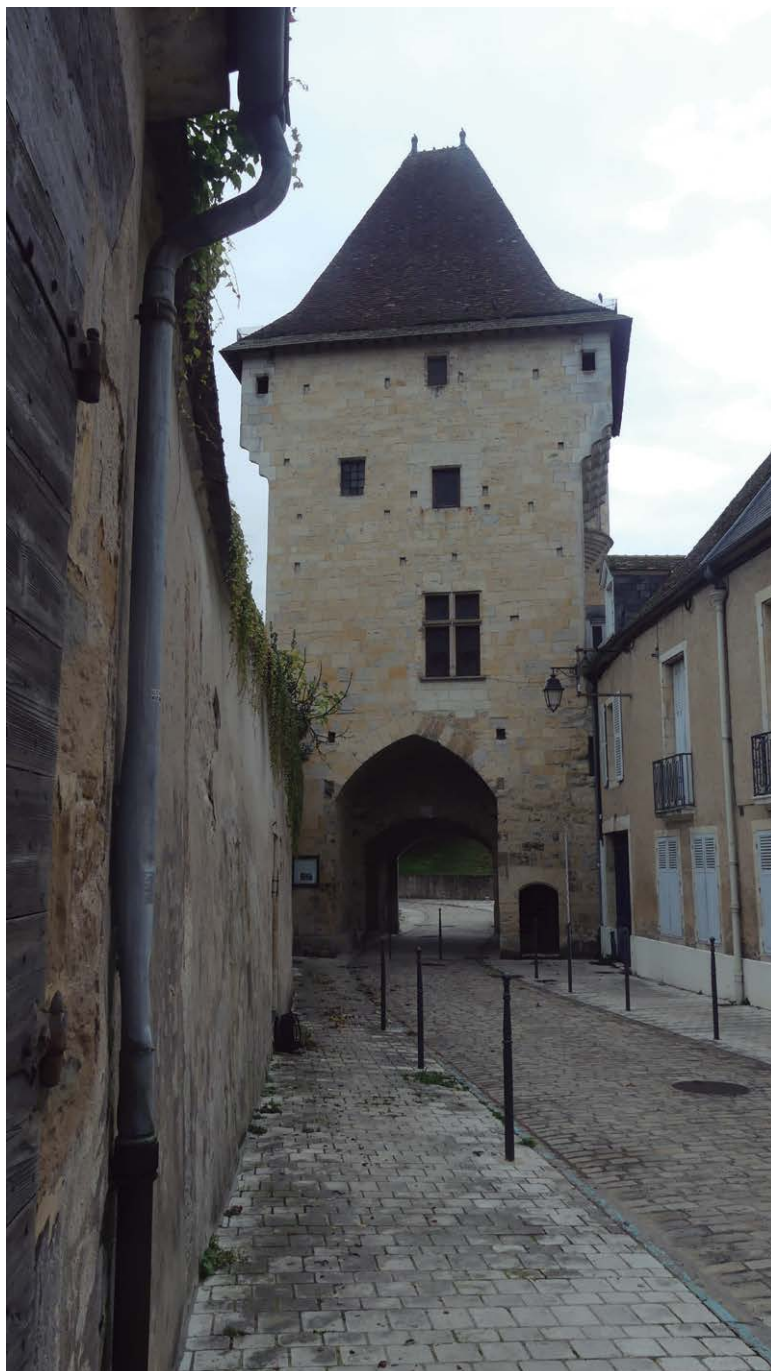
Fig. 7 – Vue de la façade Est (côté ville) de la Porte du Croix (Photo: G. Koenig).
