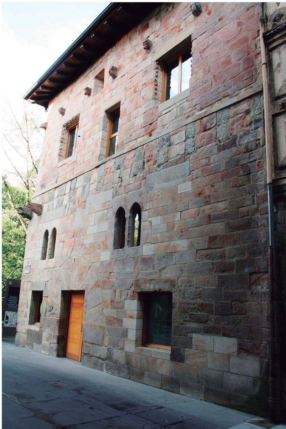
Fig. 5 – Torre de Láriz, en la que se aprecian los rasgos de un palacio urbano, especialmente en la decoración empleada en su fachada principal, que se ha conservado sólo parcialmente.
