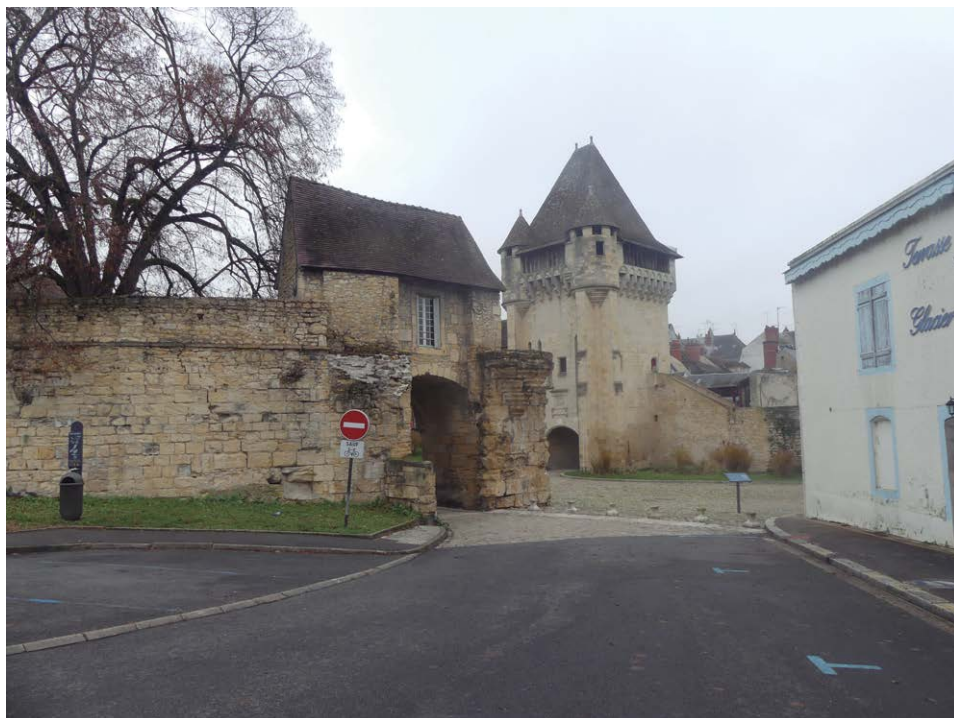
Fig. 1 – Porte du Croix de Nevers avec, au premier plan, l'entrée du boulevard d'artillerie construit en 1472-73. (Photo: G. Koenig).
