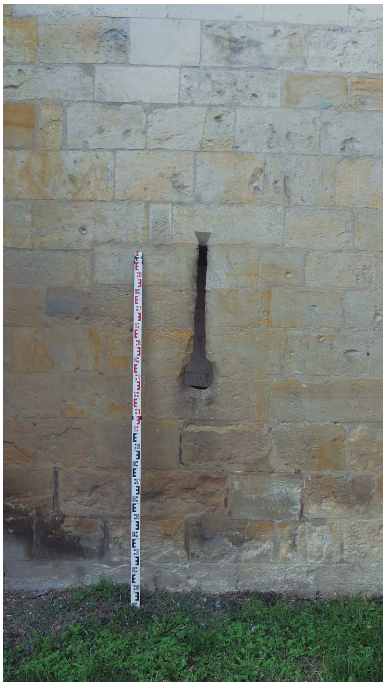
Fig. 4 – Archère-canonnière du parement Nord de la Porte du Croux (Photo: G. Koenig).
