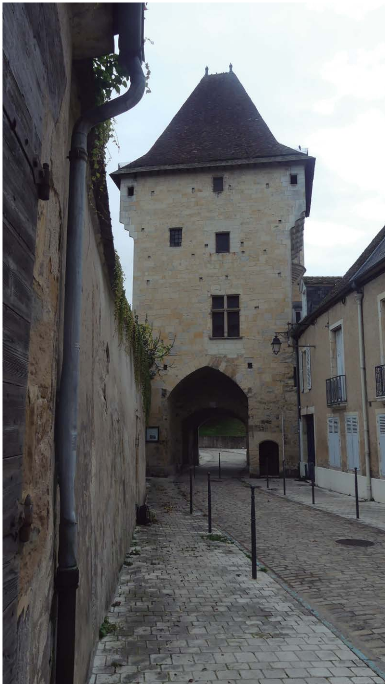
Fig. 7 – Vue de la façade Est (côté ville) de la Porte du Croix (Photo: G. Koenig).
