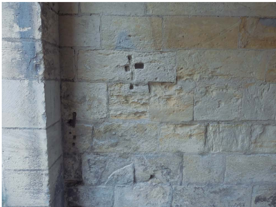
Fig. 6 – Négatif de la serrure du pont-levis.
