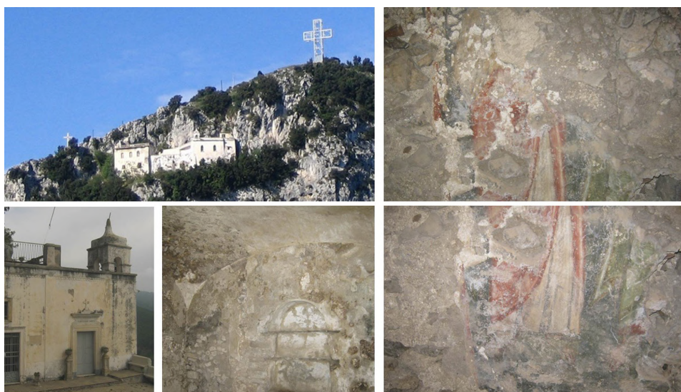
Fig. 8 – Cava de' Tirreni-Eremo di San Liberatore. Particolare degli ambienti originari costruiti a ridosso della cavità roccioso e dei lacerti di un affresco. ©Federica Comes, 2013 e https://amalfinotizie.it/eremo-di-san-liberatore-storia/ (data ultimo accesso: 05.12.2020)
