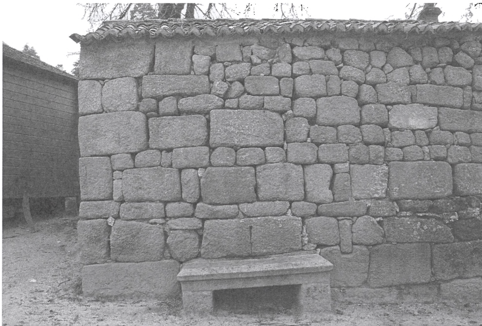
Figura 7. Paramento da capela de S. Miguel (S. Pedro do Sul), que conserva elementos do aparelho alto-medieval.
