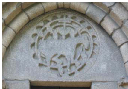
Fig. 1 Tímpano do portal lateral norte da Igreja de São Martinho de Cedofeita
