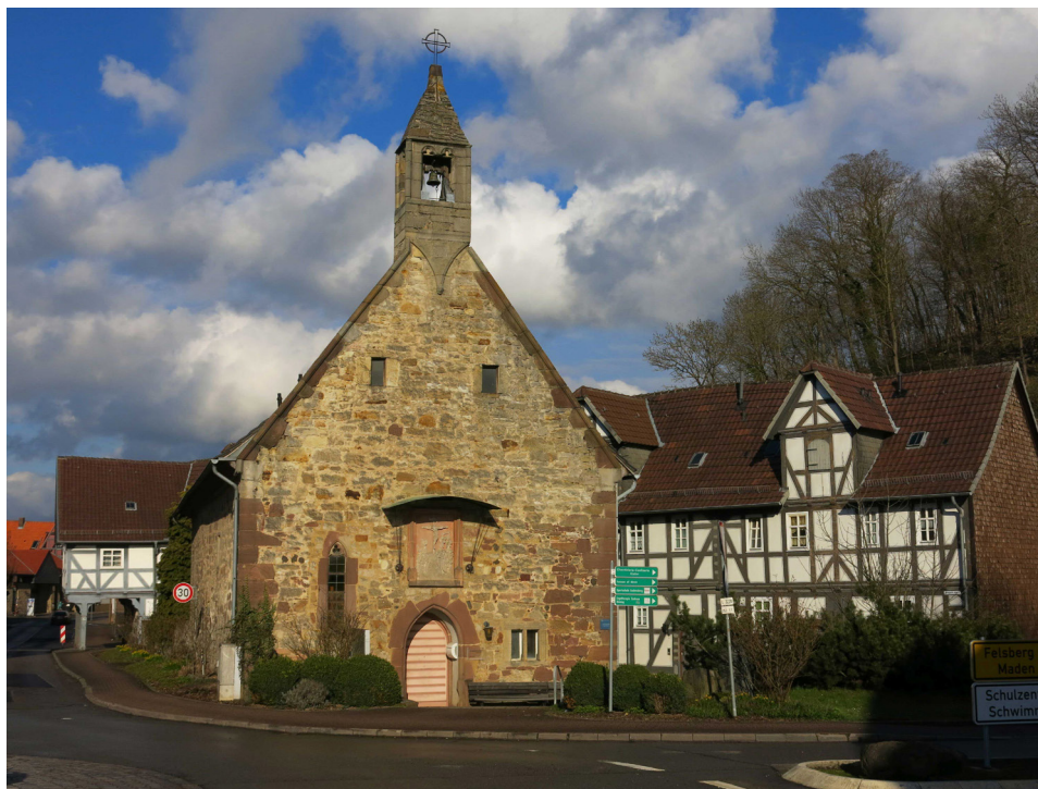
Fig. 1 – Sous-titre : Gudensberg, hôpital du Saint-Esprit. Chapelle de l'hôpital et (à droite) bâtiments hospitaliers du début des Temps modernes. Situation à une route. La chapelle est encore un lieu de culte protestant, les autres bâtiments hébergent des logements sociaux. Photo : Gisela Naegle, 2021.
