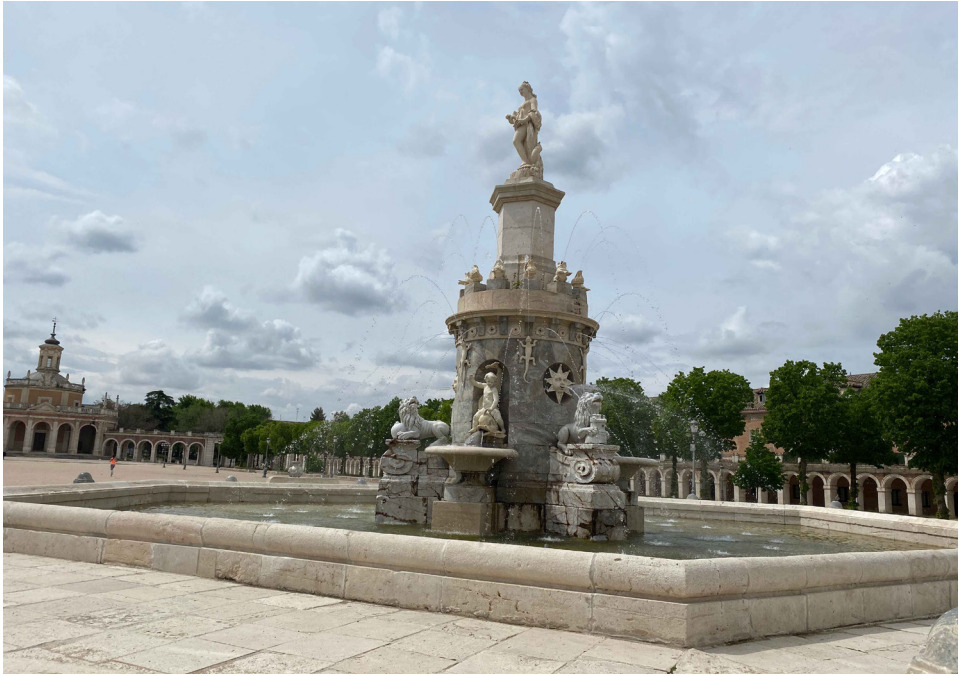
Fig. 2 – Plaza y fuente de la Mariblanca (foto de M. Merlos).
