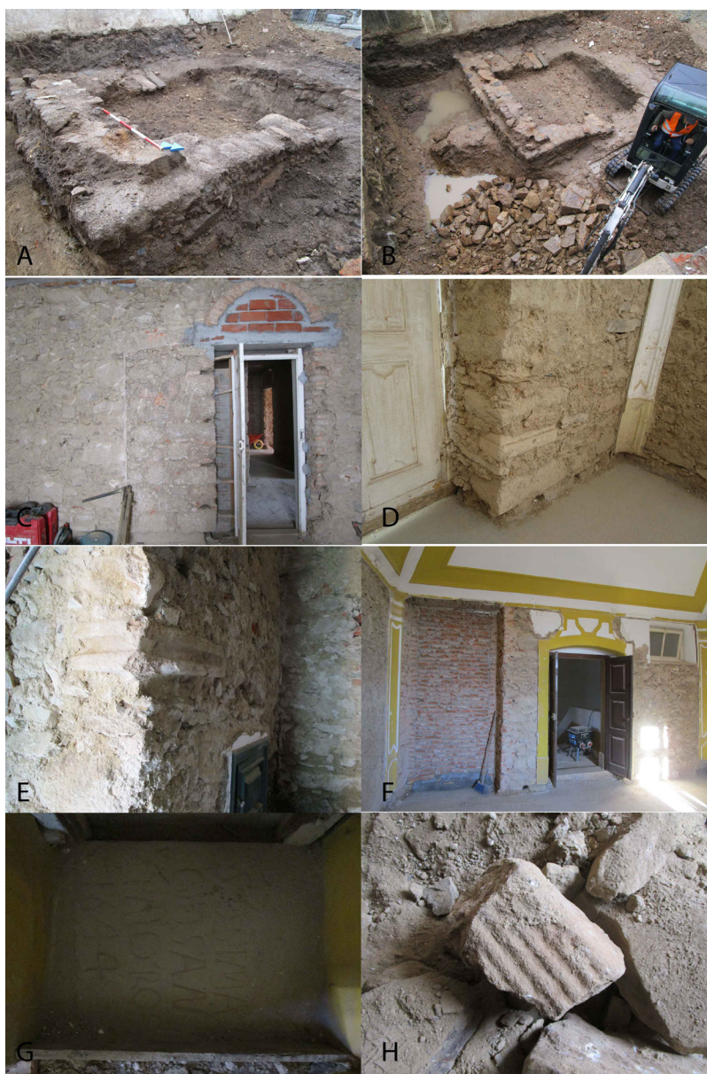
Fig. 3 – Trabalhos realizados durante o acompanhamento arqueológico: A – Minimização de impactes no património através da escavação e registo; B – Acompanhamento de obra da escavação mecânica; C - Registo de arqueologia da arquitetura dos vários momentos construtivos; D – Identificação de elementos arquitetónicos reutilizados nos paramentos; E – Impostas de granito reutilizadas num paramento; F – Vista geral de uma enfermaria após a remoção dos rebocos, que deixaram a vista vários materiais como gesso, tabique, tijolo maciço; G – Lápide funerária reaproveitada num paramento interno; H – Elementos pétreos identificados no interior de um paramento que foi demolido (Fotografias da autora).
