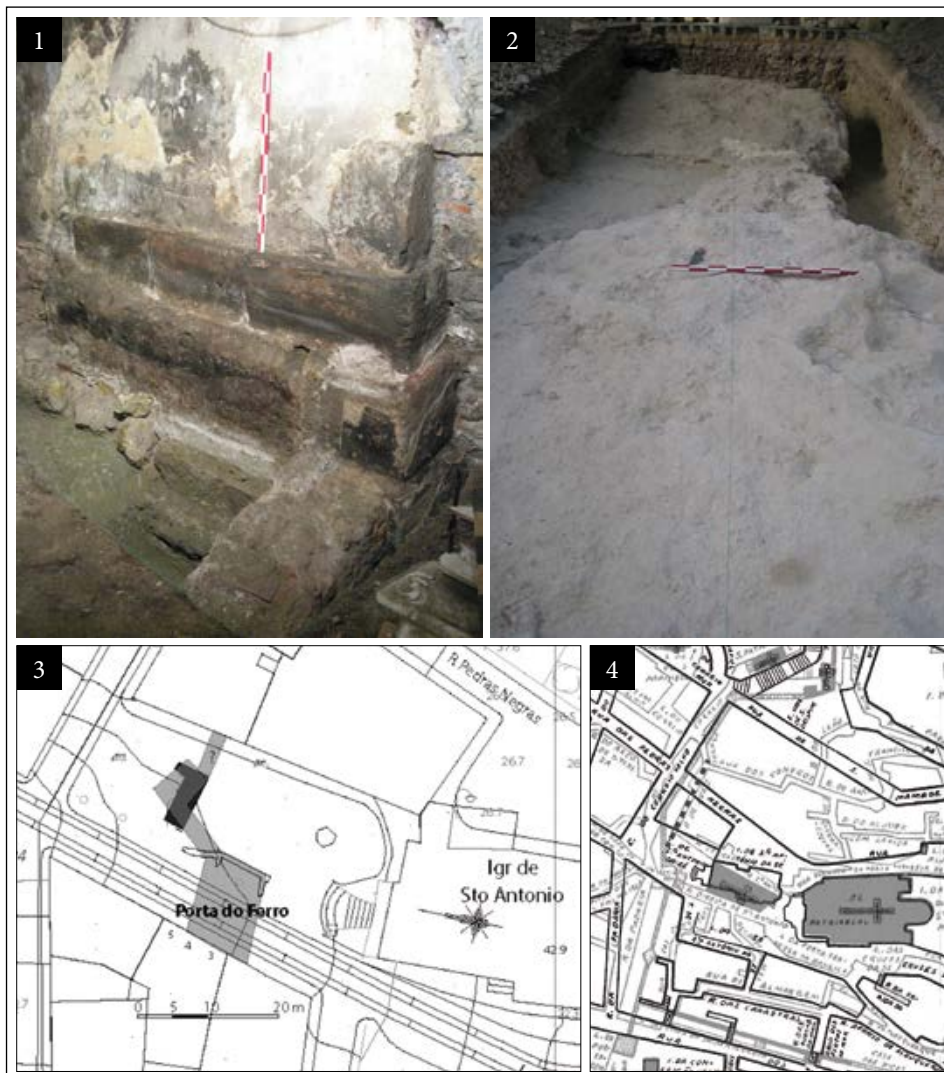
Fig. 4 – Aspeto da Torre escalonada identificada no interior do edifício sito no Largo de Santo António da sé, 3-5 (1); Vestígios dos embasamentos da muralha e da torre escavadas no Largo de Santo António da Sé (2); reconstituição do traçado da muralha na zona da Porta do Ferro, segundo os dados das intervenções arqueológicas realizadas no local (3); Desenvolvimento hipotético da muralha (a tracejado) para Norte pela antiga Rua de João Fogaça, sobre planta com urbanismo pré-terramoto de Augusto Vieira da Silva (4).
