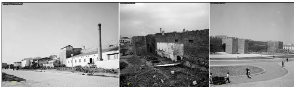
Fig. 7 – Fotografias do Sistema de Informação para o Património Arquitectónico (DGPC) registando os diferentes tempos da intervenção nas muralhas de Lagos (1957-1960).
