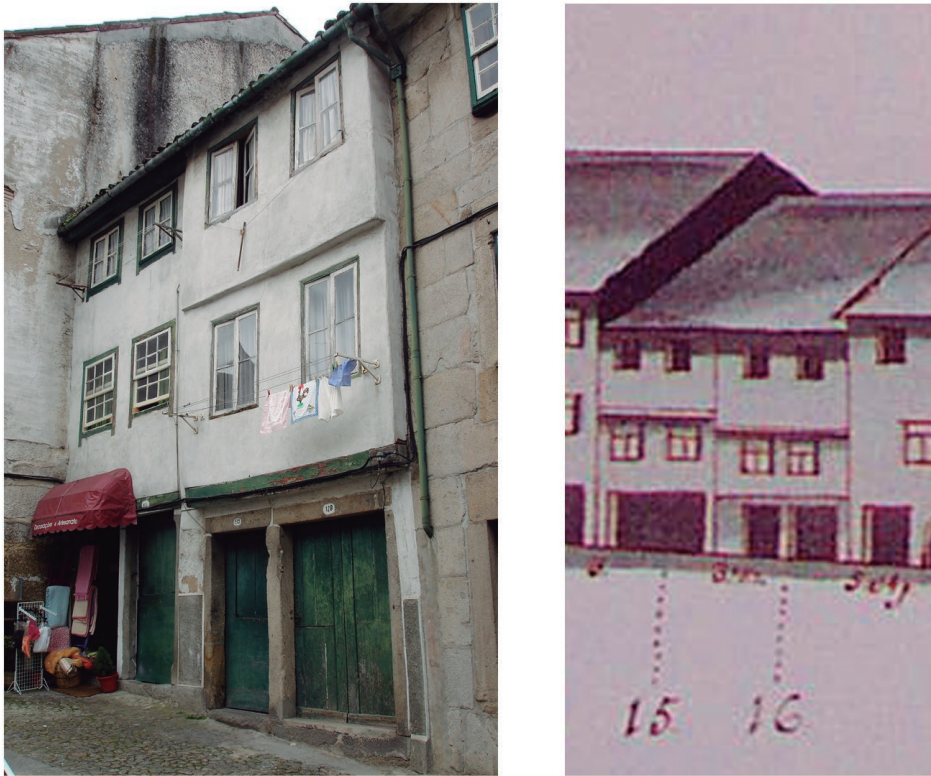
Fig. 5 – Casas de origem medieval na rua da Sapataria, em Braga. À esquerda: em 2008; à direita, em 1750, segundo o Mappa das Ruas de Braga .
