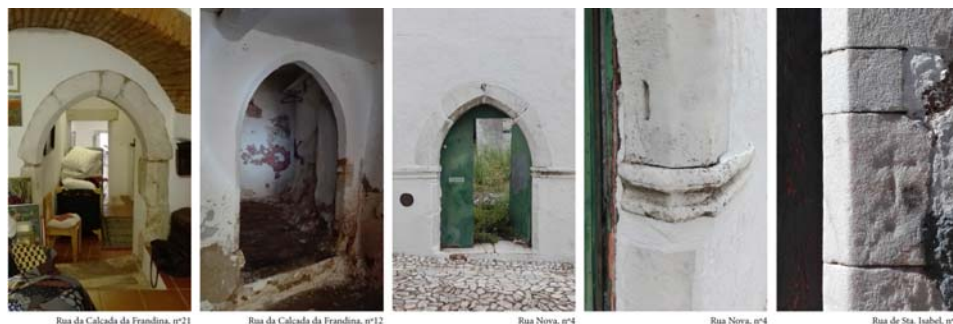
Fig. 4 - Arcos ogivais em mármore e tijolo. Marcas em cantarias exteriores
