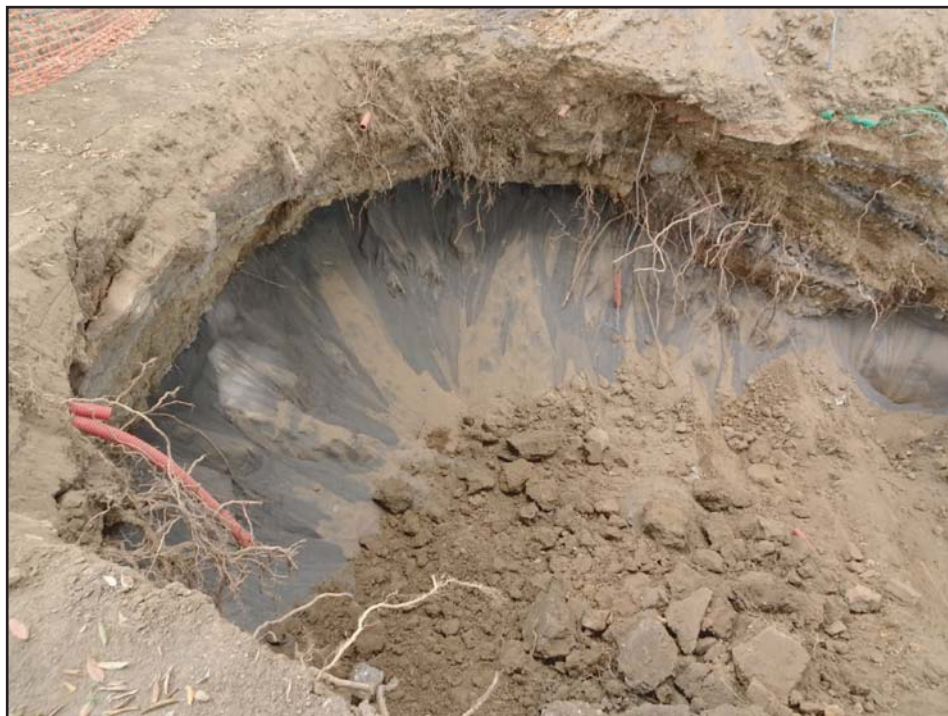
Fig. 4 - Aspeto da escavação da Vala 01, com a identificação de um nível de areia na base, possivelmente correspondente à área ocupada pelo portinho do Beliago.
