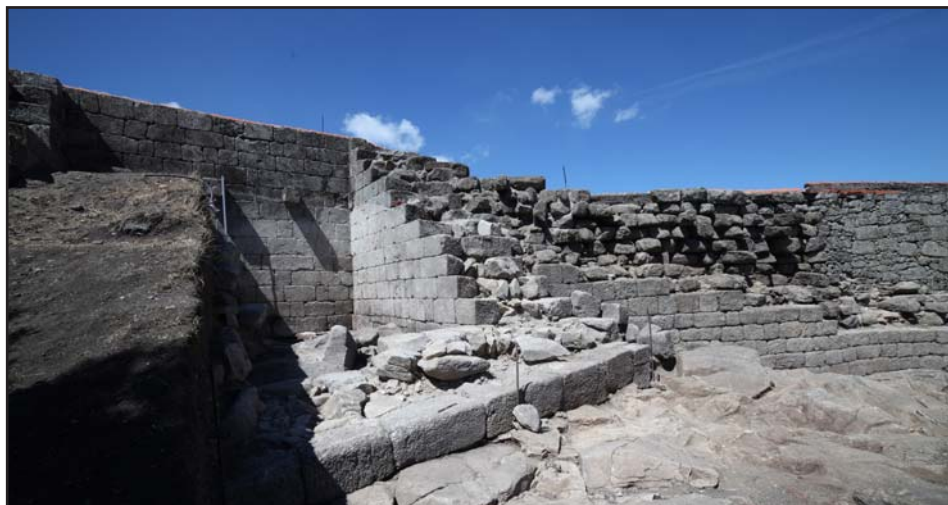
Fig. 3 - Aspecto actual da Torre Velha
