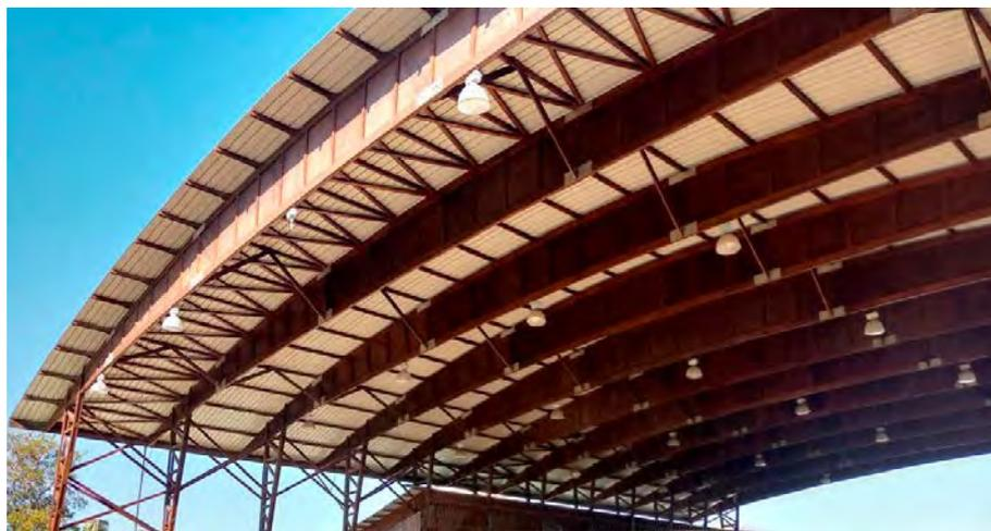
Figuras 23 e 24 – Relação entre a caverna de uma embarcação de madeira e a viga principal do edifício, cuja configuração, efeito e lógica de funcionamento estrutural se aproxima ao de uma asna.
