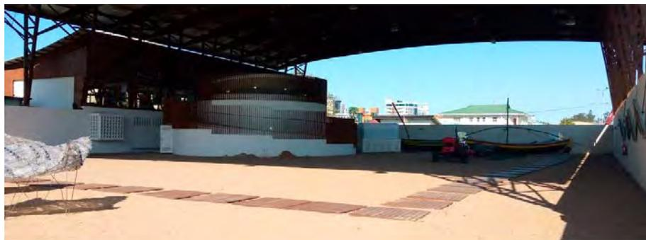
Figura 26 – Piso do pátio interior feito em areia branca limpa, de empréstimo, assente em camada de manta geotêxtil.
