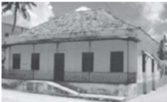
Figura 1 e Figura 2 – Casa de pedra e cal, com influência da casa swahili, localizada na ilha do Ibo. Os elementos de derivação swahili são reconhecíveis nas portas e janelas, fachadas elevadas, veranda e no telhado de quatro águas com solução para protecção solar e ventilação natural (Fonte: Carrilho, Bruschi, Meneses & Lage, 2004; Desenho e fotografia: Júlio Carrilho).
