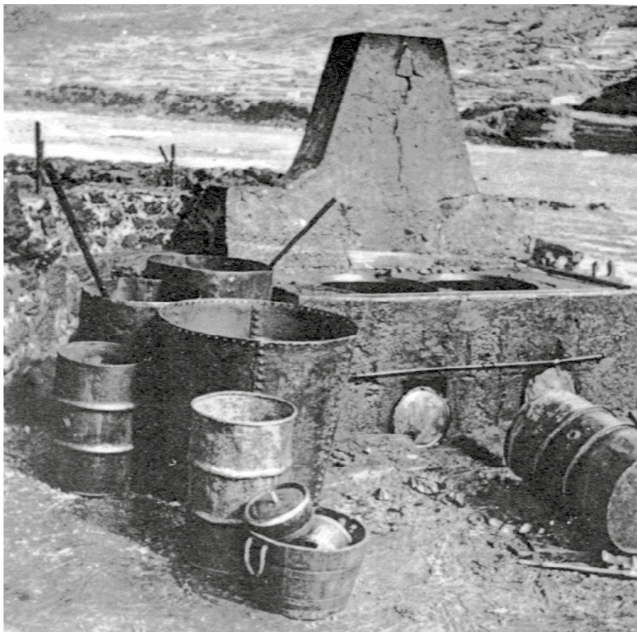
Figura 7 – Fornalha de extração de azeite de baleia (traiol) e recipientes para o seu arrefecimento e purificação (culas) (Lajes do Pico, 1949). Clarke (2001 [1954]: Gravura VI, fig. 2).
