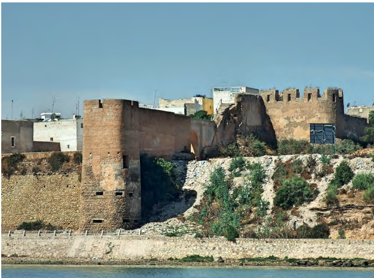
Fig. 20 – Torre NE junto ao rio. / Tour NE près du fleuve.
