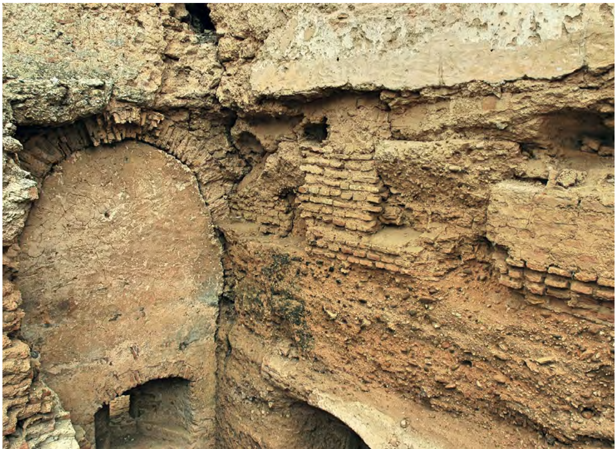
Fig. 24 – Muros em taipa, arco de fundação em tijolo e arranque da abóbada de canhão em tijolo da torre, no paramento Oeste e canto Sudoeste do baluarte do Raio. Murs en pisé, arcs de fondation en brique et départ de la voûte cylindrique en brique de la tour, dans le mur ouest et dans l'angle sud-ouest du bastion du Raio.
