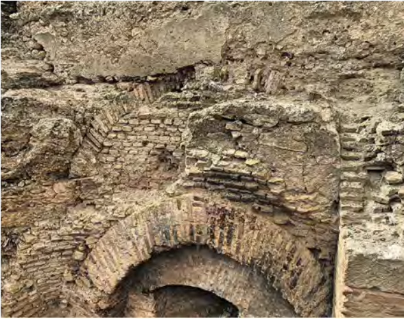
Fig. 25 – Arco de fundação (plano afastado) e arco ultrapassado de sustentação da abóbada (plano próximo) da torre, no paramento Sul do baluarte do Raio. Arc de fondation (plan éloigné) et arc outrepassé de soutien de la voûte (plan proche) de la tour, dans le mur sud du bastion du Raio.
