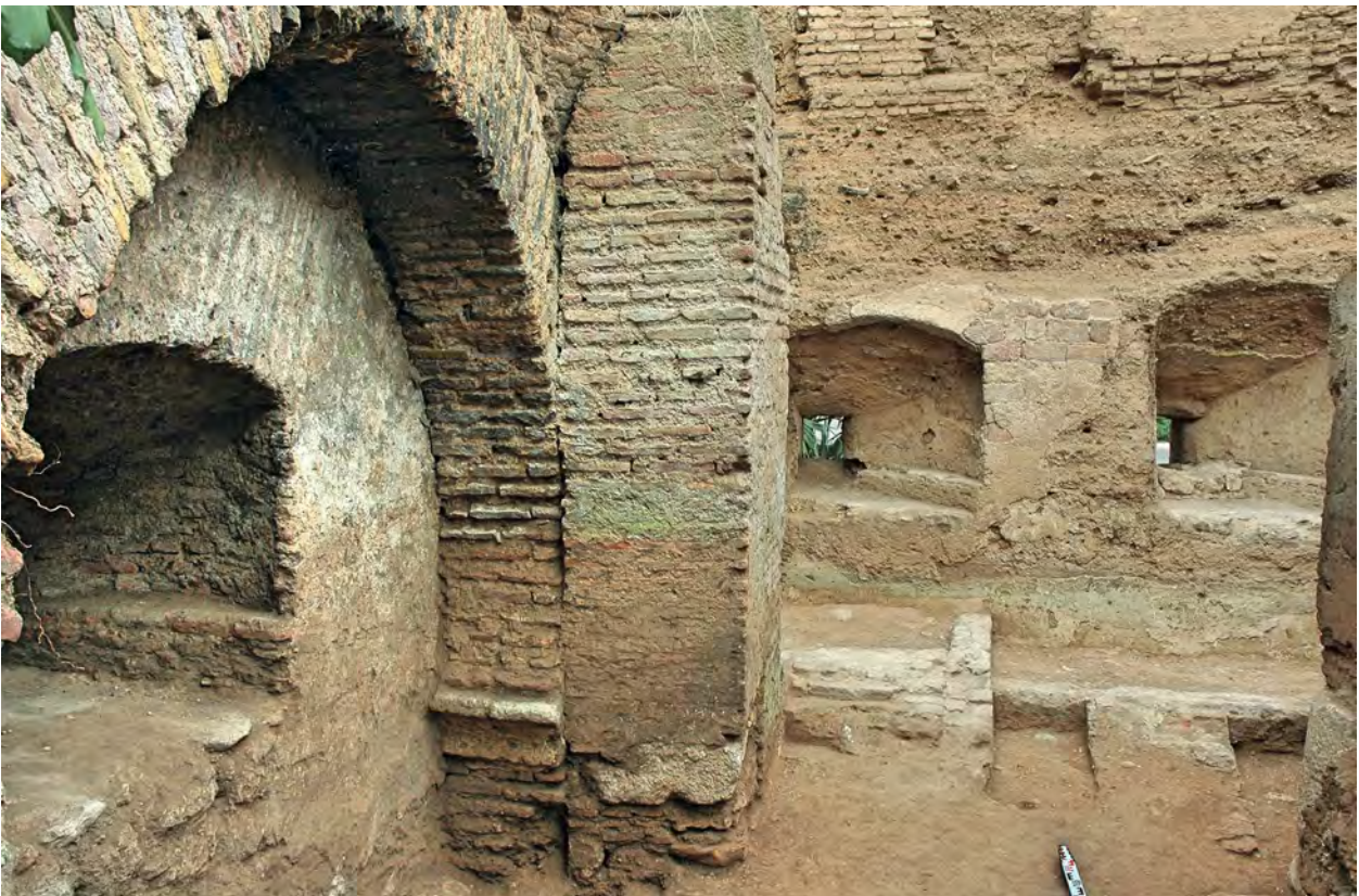
Fig. 26 – Pilar encostado ao paramento Sul do baluarte do Raio. Pilier appuyé sur le mur sud du bastion du Raio.
