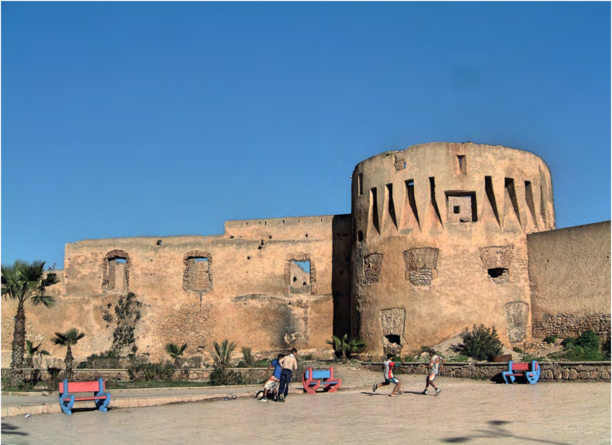
Fig. 32– Casa dos capitães e baluarte de São Cristóvão vistos do exterior. Capitainerie et bastion de São Cristóvão vus de l'extérieur.
