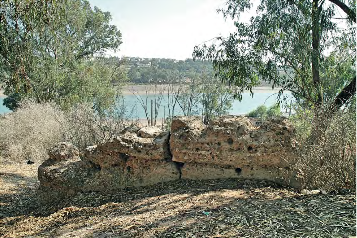
Fig. 6 – Troço da muralha em taipa a Sudeste. Section de la muraille en pisé à sud-est.
