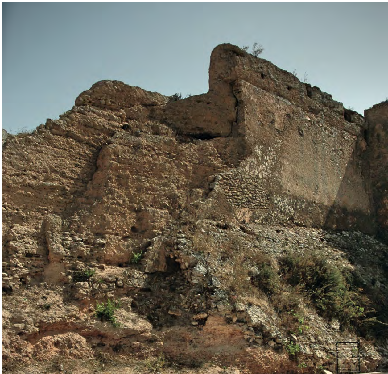
Fig. 16 – Troço Norte da muralha da medina, com superfície externa e alambor em alvenaria de pedra e núcleo em taipa. Section nord du rempart de la médina, avec la surface externe et le talus en maçonnerie de pierre et le noyau en pisé.
