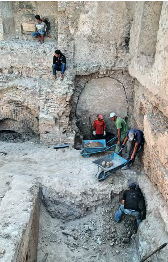
Fig. 19 – Interior sul do baluarte do Raio no início dos trabalhos. Intérieur sud du bastion du Raio au début des travaux.
