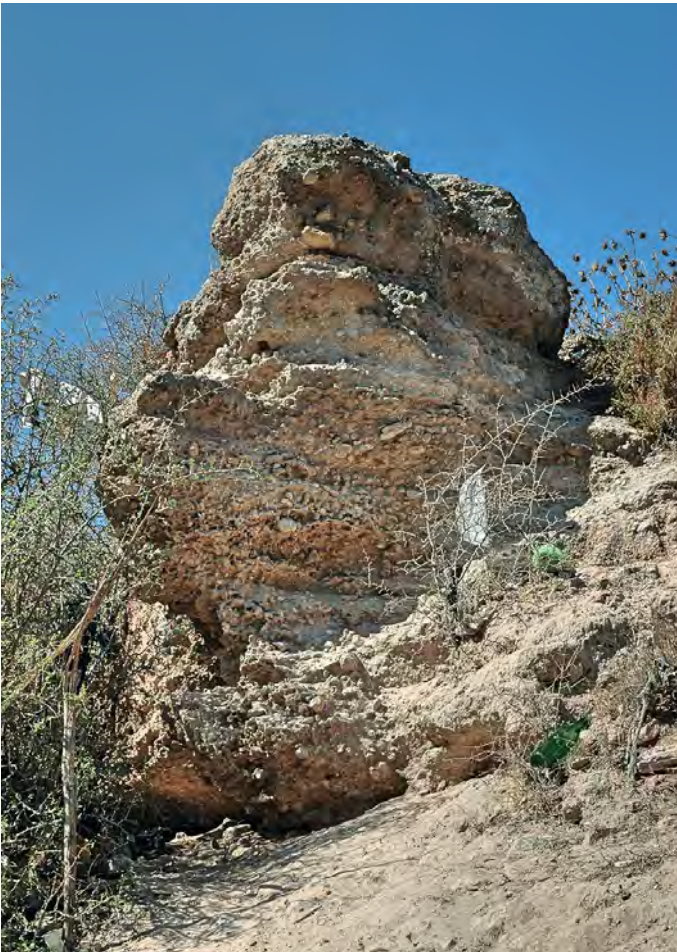
Fig. 7 – Torre da muralha em taipa a Sudeste. Tour de la muraille en pisé à sud-est.
