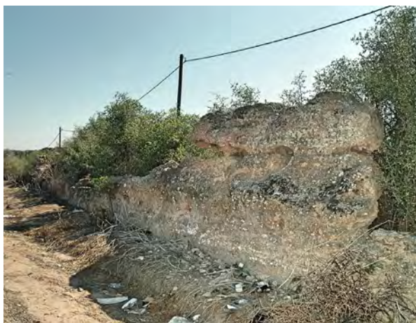
Fig. 8 – Troço da muralha em taipa a Sul, junto à Boulevard Moulay Al-Hassan. Section de la muraille en pisé au sud, près de la Boulevard Moulay Al-Hassan.
