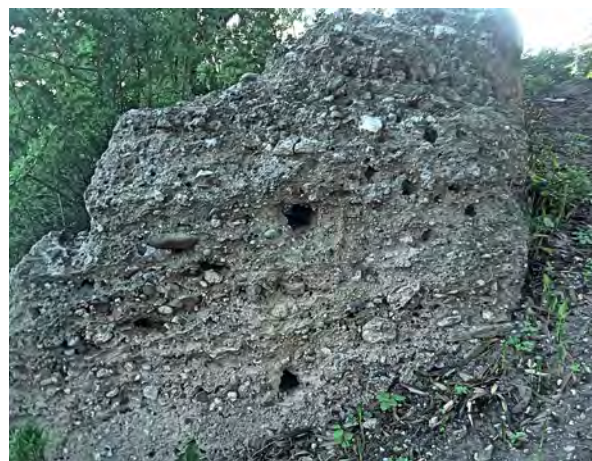
Fig. 9 – Detalhe de um troço da muralha em taipa. Detaille d'une section de la muraille en pisé.
