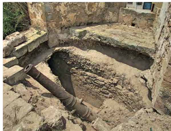
Fig. 31 – Coroamento da parte arredondada Norte do baluarte do Raio, vendo-se canhoneira posterior à construção portuguesa. Achèvement de la plate-forme arrondie nord du bastion du Raio, s'observant une embrasure postérieure à la construction portugaise.
