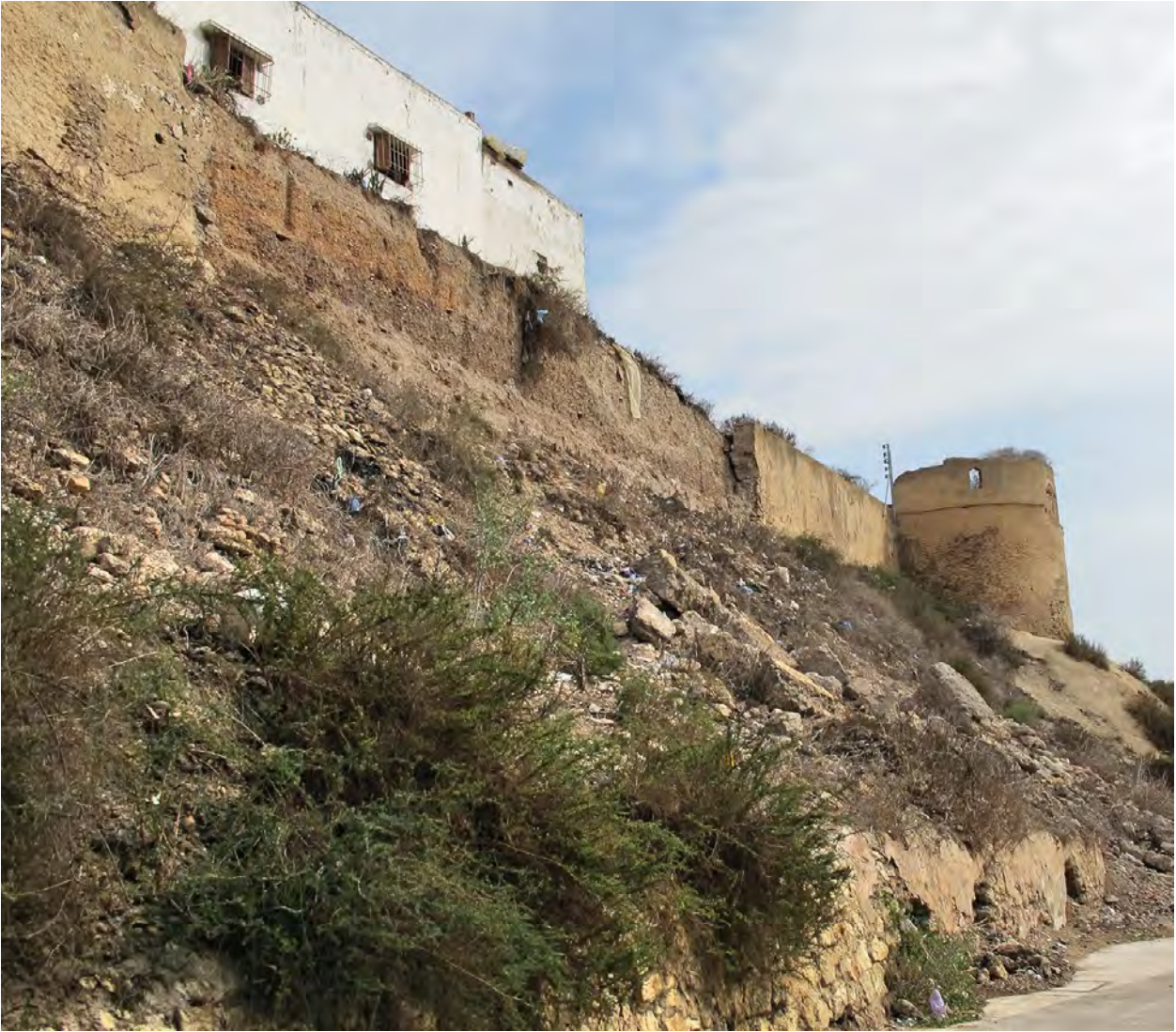
Fig. 17 – Troço Sul da muralha da medina, com superfície externa e alambor em alvenaria de pedra e núcleo em taipa. Section sud du rempart de la médina, avec la surface externe et le talus en maçonnerie de pierre et le noyau en pisé.
