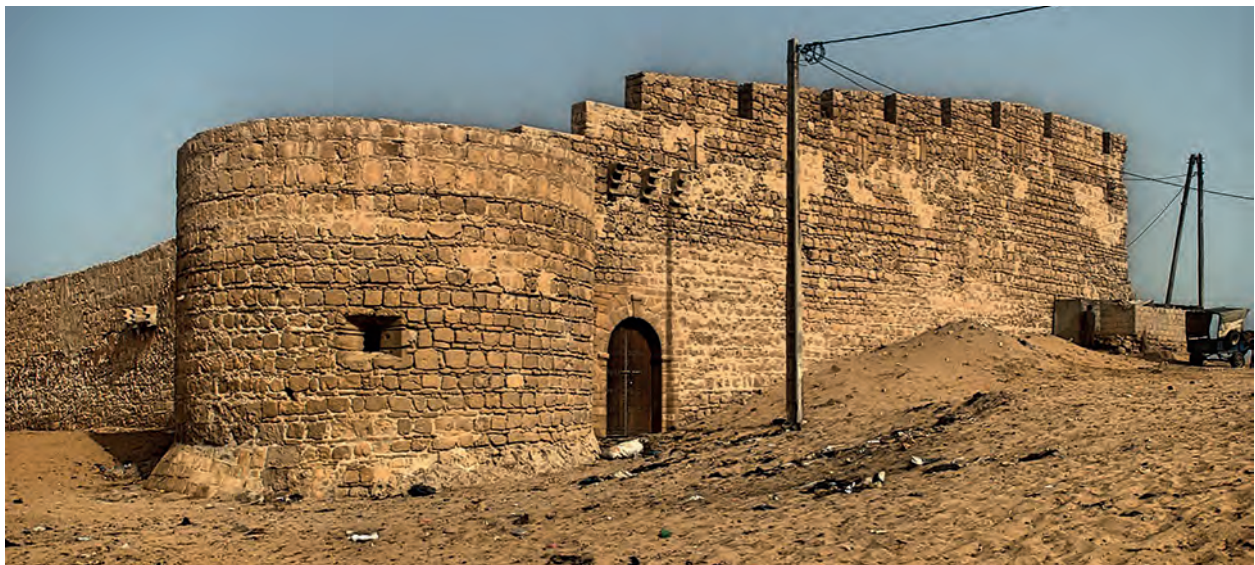
Fig. 5 – O «Castelo Novo» de Aguz (Soeira Quedima, Marrocos). / Le «Château fort nouveau» d'Agúz (Souira Qdima, Maroc).
