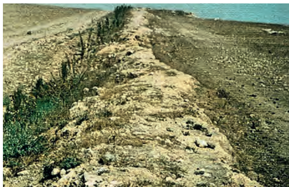
Fig. 3.1 – Vestígios da muralha de Cernu. / Traces de la muraille de Sernou.
