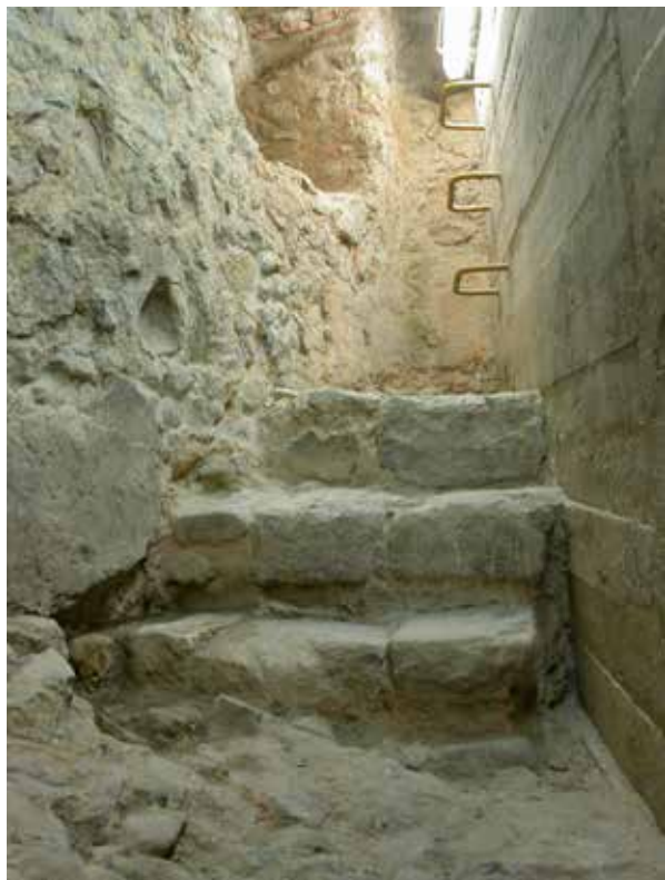
4. Perspectiva de poente para nascente dos degraus do interior da habitação. © Fotografia José Avelar
