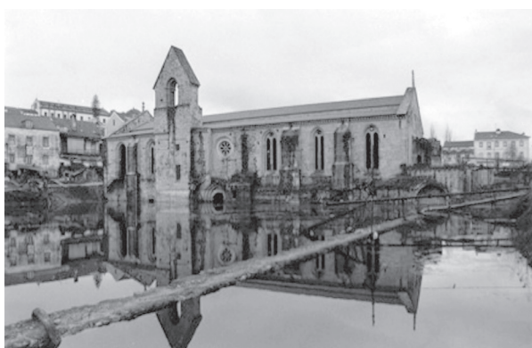
1. A Igreja do Mosteiro de Santa Clara-a-Velha no seu ambiente singular, antes da operação de requalificação.
