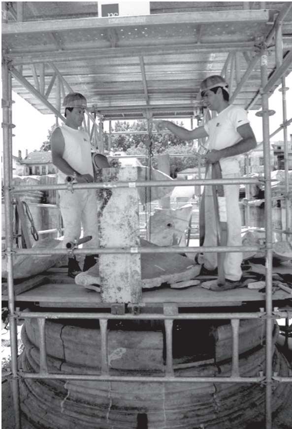
5. Intervenção de conservação e restauro na Casa do Lavabo.
