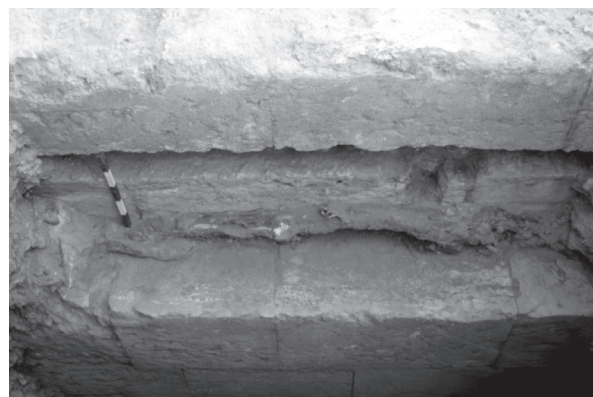
2. Sondagem 1 – Primeiro patim da Doca Seca (UE 103) quanto ao topo da estrutura. Orientação Oeste – Este.
