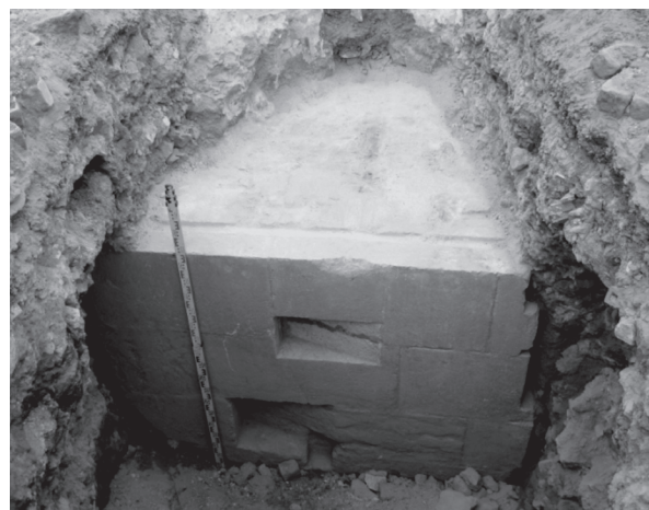
3. UE 606 – Vista geral. Orientação Oeste – Este.
