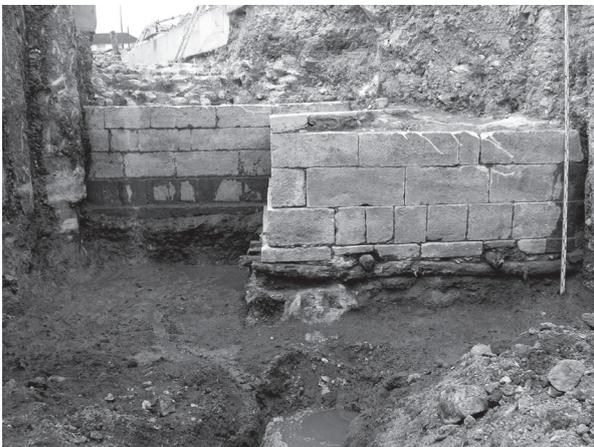
5. Paredão e Cais. Ao fundo, o Paredão com a parte superior destruída, tendo sido, somente, recuperado o preenchimento. Em primeiro plano, o Cais, sendo visível a sua base em estacaria e traves de madeira.
