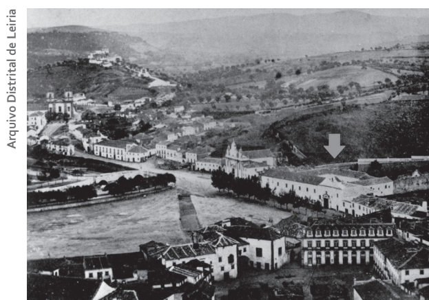
3. O Convento de Santana em fotografia de c. 1880.
