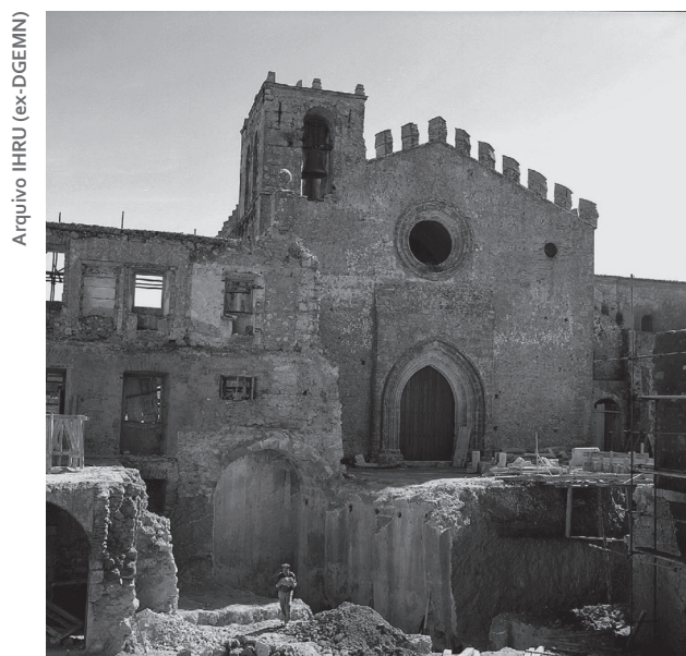
15. Aspecto da cisterna em imagem dos anos 70.
