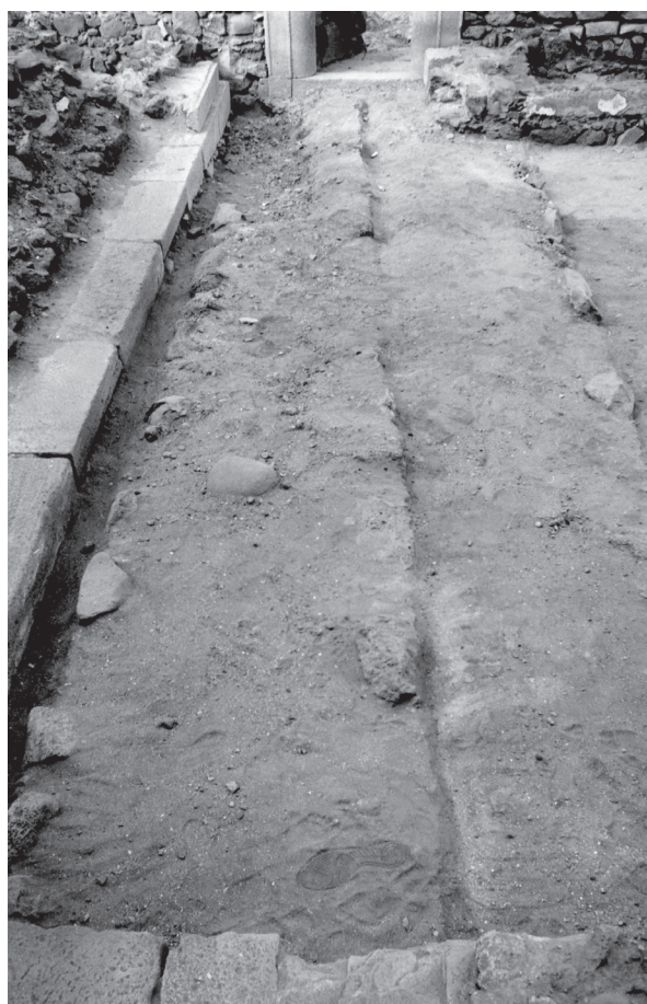
7. Pormenor da preparação do assentamento dos degraus de acesso ao altar-mor.
