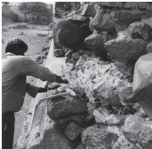
17. Preenchimento de vazios numa parede exterior do edifício.
