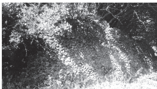
26. O muro delimitador da cidade de Takwa, na ilha de Manda, construído no século XVII (2002).
