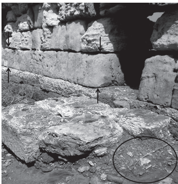
23. “Couraça do mar” – sinais dos grampos e da argamassa que uniam os blocos (2010).
