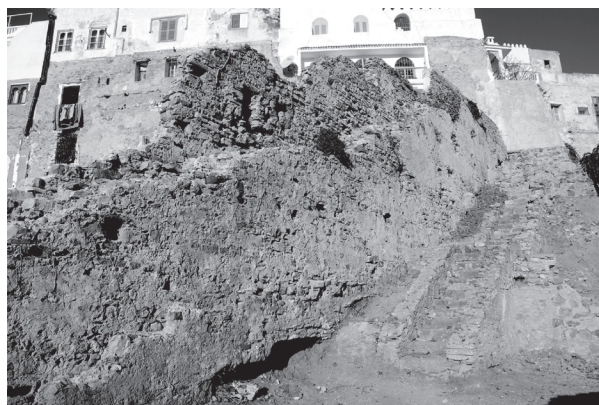
9. Coracha de Tanger - Vue sur le mur Sud et l'escalier.
