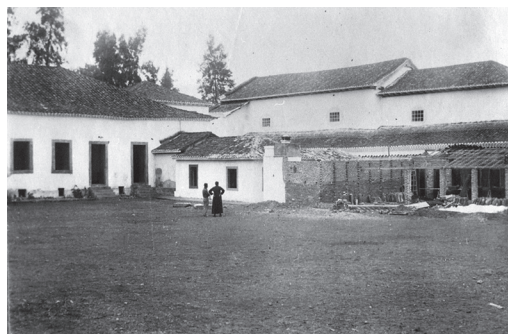
4. Fachada posterior – intervenções posteriores.
