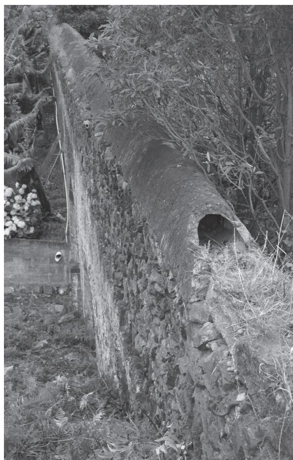
4. Caleira de secção circular protegida por reboco tosco.
