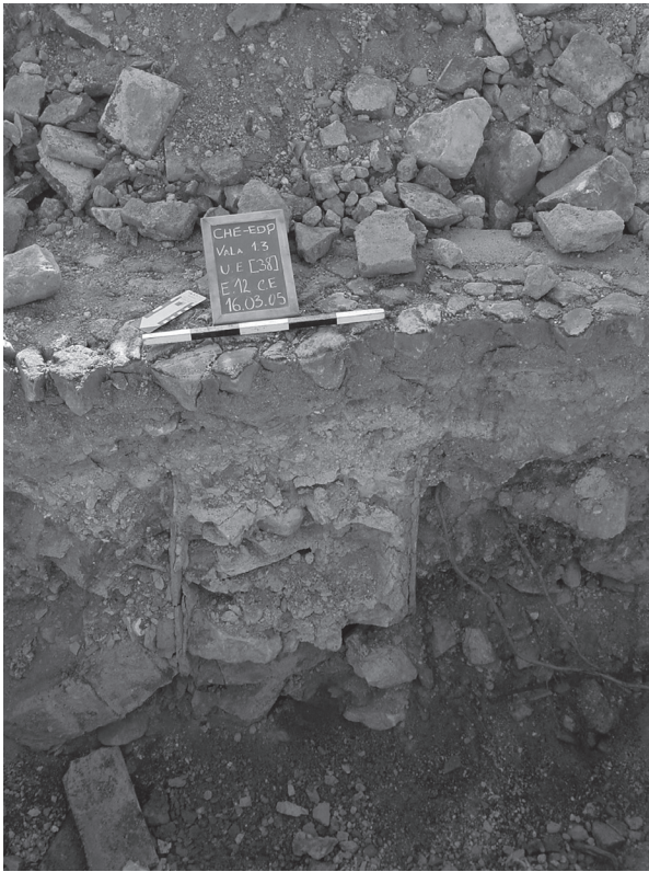
3. Pormenor em corte estratigráfico de parede em alvenaria de pedra e tijolo pertencente aos Quartéis da Parada do Castelo.
