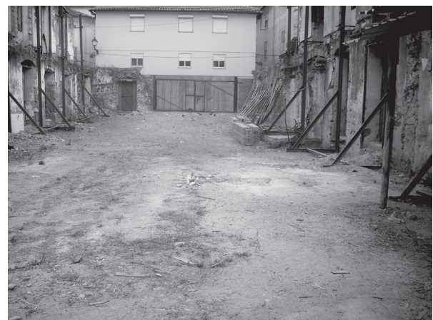
12. Vista geral da área intervencionada, reconhecendo-se as fachadas do edifício, que se mantiveram após o incêndio que o destruiu.
