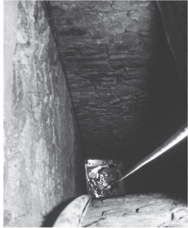
4. Interior do poço.
