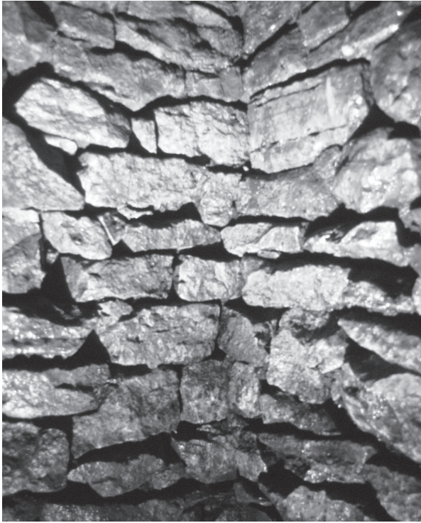
3. Pormenor do troço inferior, construído em pedra seca.
