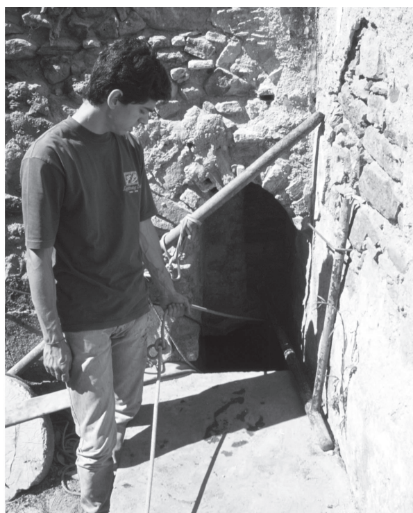
2. Entrada do poço, na fachada lateral da padaria.
