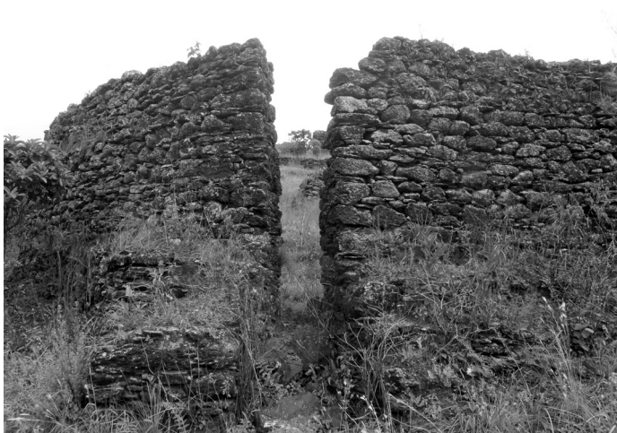
2 Ouverture de décantation d'un mundeú circulaire du morro das passagens entre Ouro Preto et Mariana. Photo credit: M. Carles, 2012.
