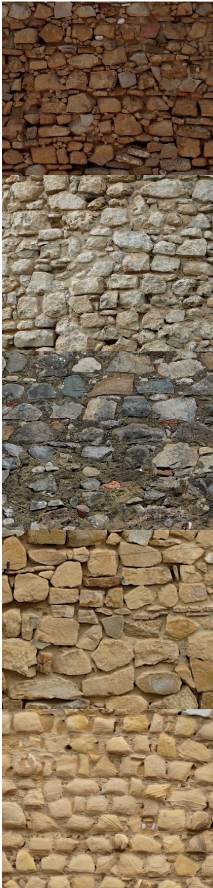
6. Padrões construtivos A, B, C, D e E (de cima para baixo). Construction patterns A, B, C, D and E (from top to bottom).
