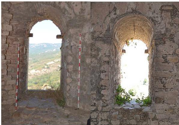
23. Vista de la ventana occidental y septentrional respectivamente desde el interior de la segunda planta. Obsérvese la diferencia de cotas entre ambas, pensada para no provocar una irregularidad en el acceso a la azotea, ubicado a mano izquierda de la ventana occidental.
