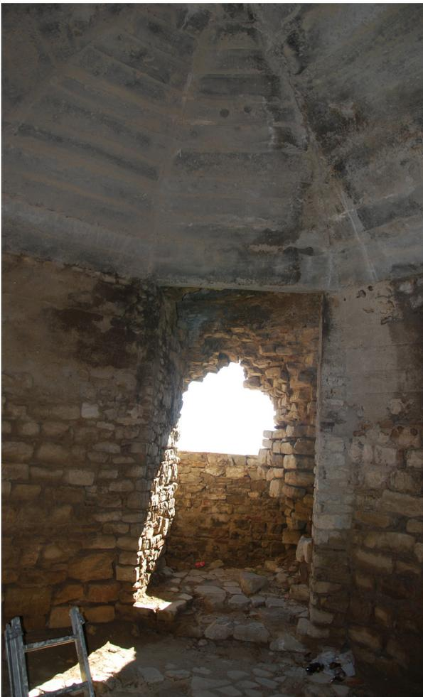
22. Vista general de la planta primera. Al igual que en planta baja, el análisis estratigráfico revela su construcción en una única fase, a excepción de la reforma sufrida de la bóveda, llevada a cabo a fines del siglo XX.
