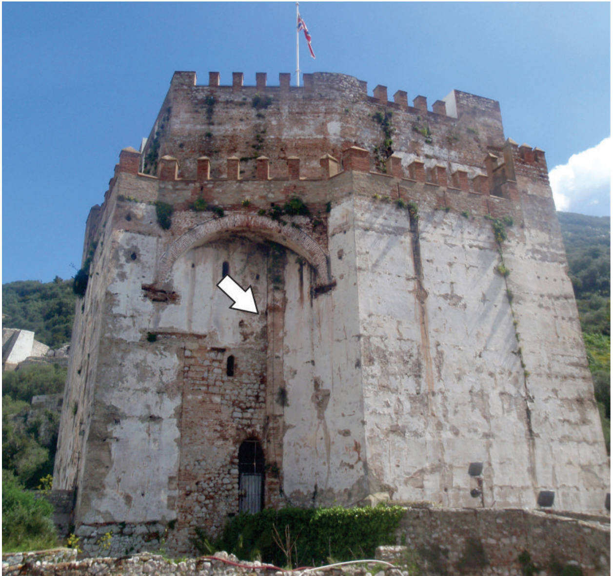
6. Vista exterior de la Calahorra y esquina emergente de la torre amortizada.
