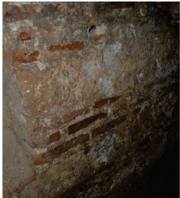
5. Paramento interior de la torre amortizada.
