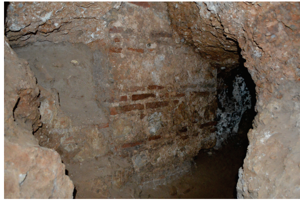
4. Paramento interior de la torre amortizada (aparejo mixto de ladrillos y mampostería).
