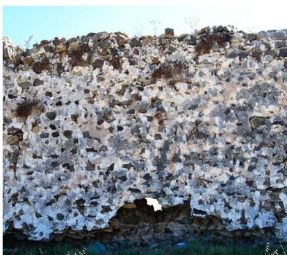
Photo 9. Matériaux et techniques de construction – enduit à base de chaux.
