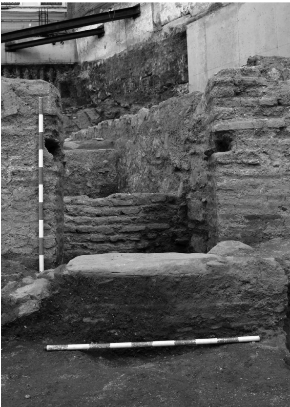
Lámina 23. Umbral de acceso al edificio B. © FIGLINA S.R.L.
