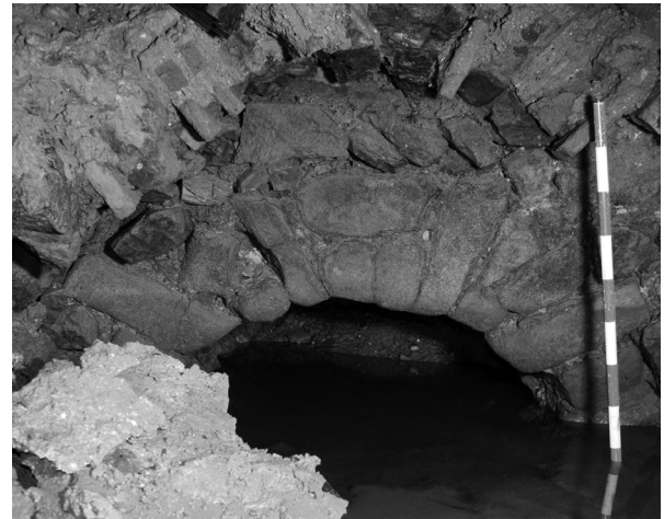
Lámina 16. Conducción de aguas sucias bajo la calle principal CP1. © FIGLINA S.R.L.
