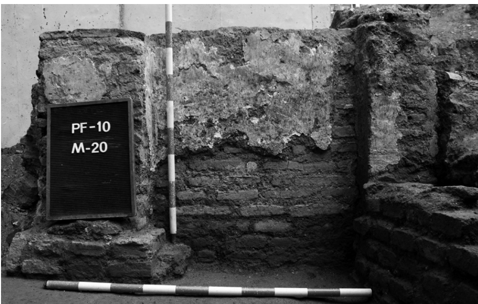
Lámina 32. Arriba. Fábrica de mampuestos y encintado de ladrillos. Centro. Recrecimiento de adobe en un muro (edificio B). Abajo. Fábrica de ladrillos en uno de los muros de subdivisión del edificio E.
