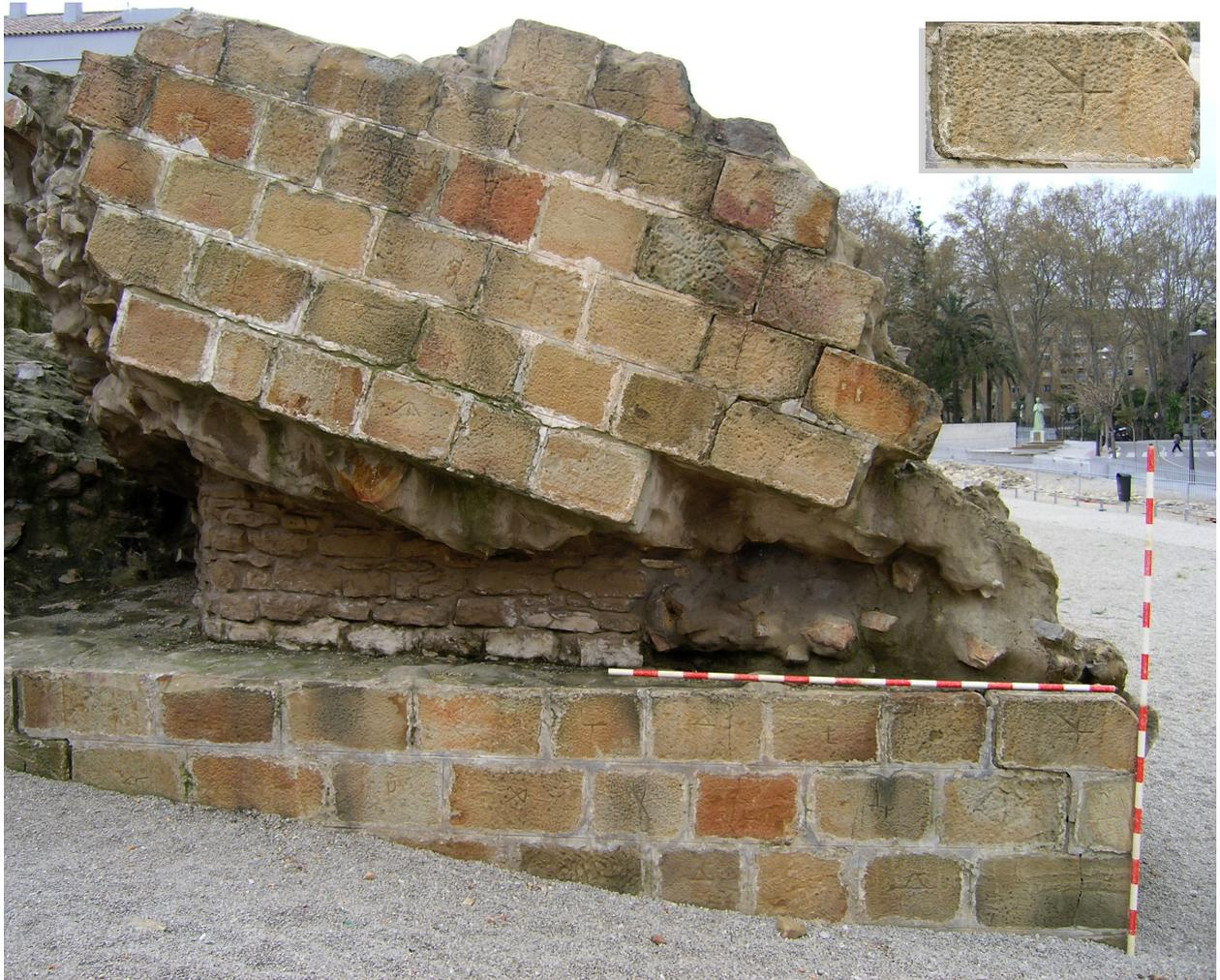
Lámina 44. Torre de flanqueo castellana. Obsérvese la fábrica con aparejo de sillería signada con marcas de cantero.
