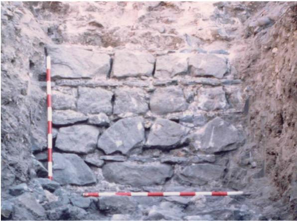
Lámina 25. Hoja exterior de mampostería de la barbacana BC3, en el sondeo mecánico SM2, de la intervención del año 1999 (cortesía de José María Tomassetti). En este tramo se comprueba una ordenada alternancia de filas de mampuestos y lajas.
