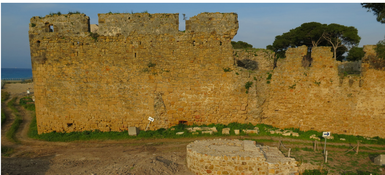
45. Mur sud-ouest du château, superposant la barbacane (à gauche) et la muraille de la ville (à droite).
