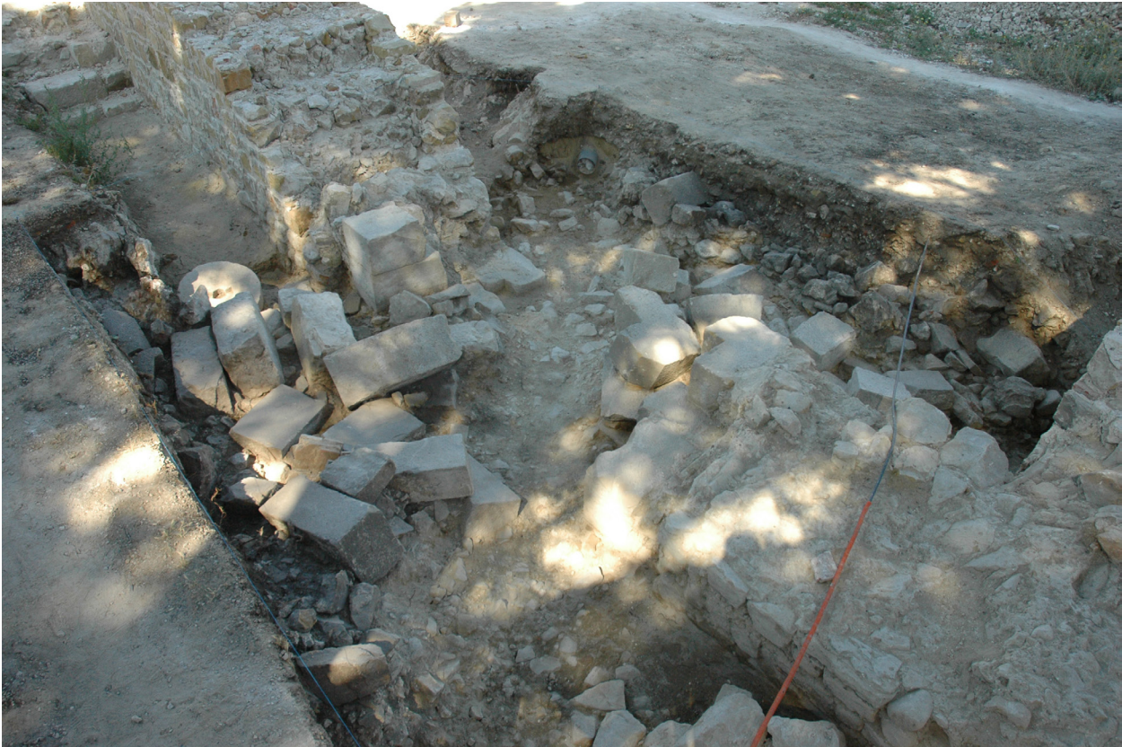
4. Destruction de la porte riveraine.
