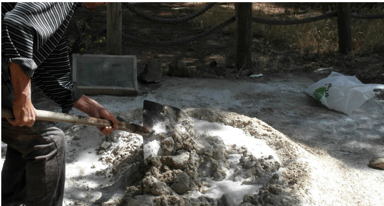
122. Fabrication du mortier pour la restitution des murs de la maison Est (n.º308) du secteur E17N10-E18N10-E18N9, en 2014.
