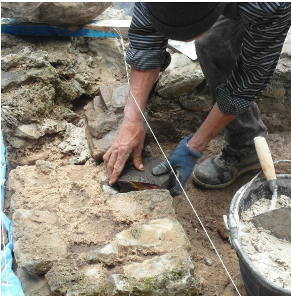
120. Réintégrations de l'appareil dans les murs de la maison Est (n.º308) du secteur E17N10-E18N10-E18N9, en 2014.
