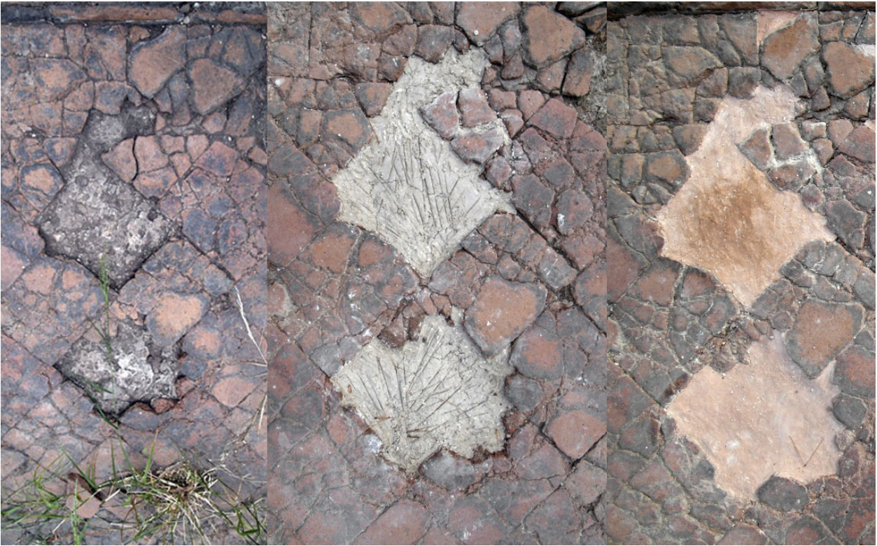
127. Remplissage des lacunes du pavement en brique de la cour de la maison Est (n.º308) du secteur E17N10-E18N10-E18N9, avec du mortier pigmenté, en 2015.
