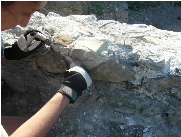
123. Remplissage des joints des murs de la maison Est (n.º308) du secteur E17N10-E18N10-E18N9, en 2015.
