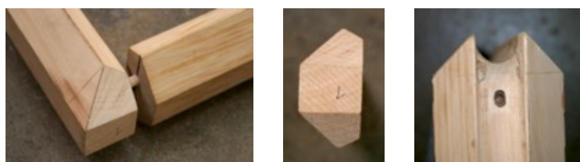
Figs. 9, 10 e 11 - A estrutura hexagonal e o sulco que confina a câmara-de-ar. (fot. Rui Silva)
