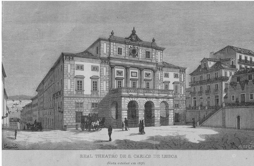
Fig. 6. Real Theatro de S. Carlos de Lisboa (vista exterior em 1878).
