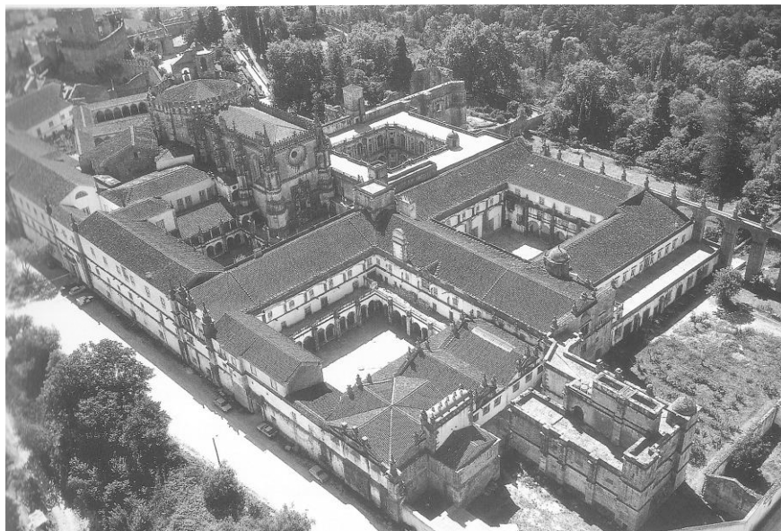
Fig. 30 – Imagem do Convento de Cristo com os vários claustros construídos na época joanina com finalização no período filipino (na actualidade).
